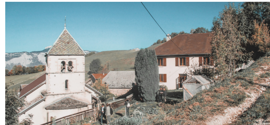
2 Réaménagement du coeur de village Saint-Jean-le-Vieux Isère
