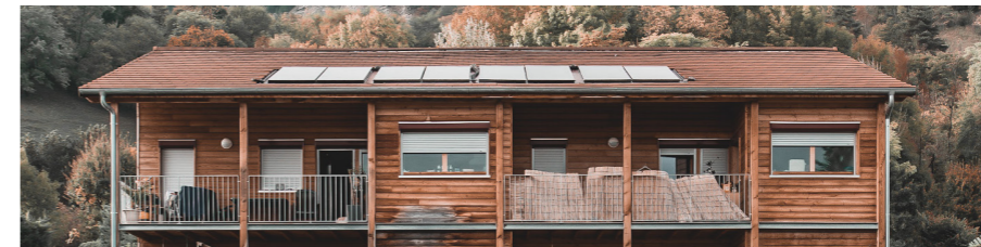
1 Construction de six logements sociaux passifs
