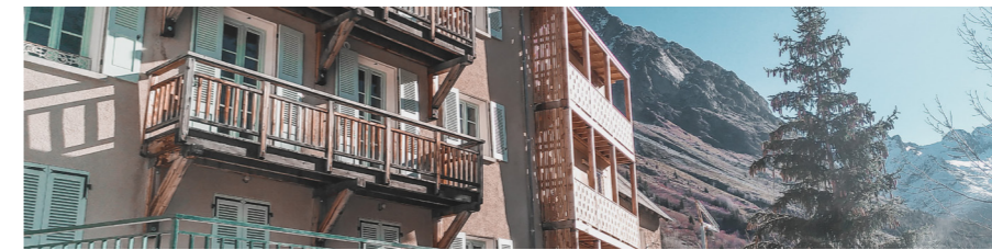
5 Réhabilitation d'un ancien hôtel du XIXe siècle
